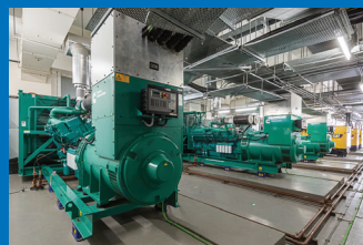
N+1水冷及风冷系统
