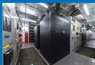
不间断电源 (UPS)
